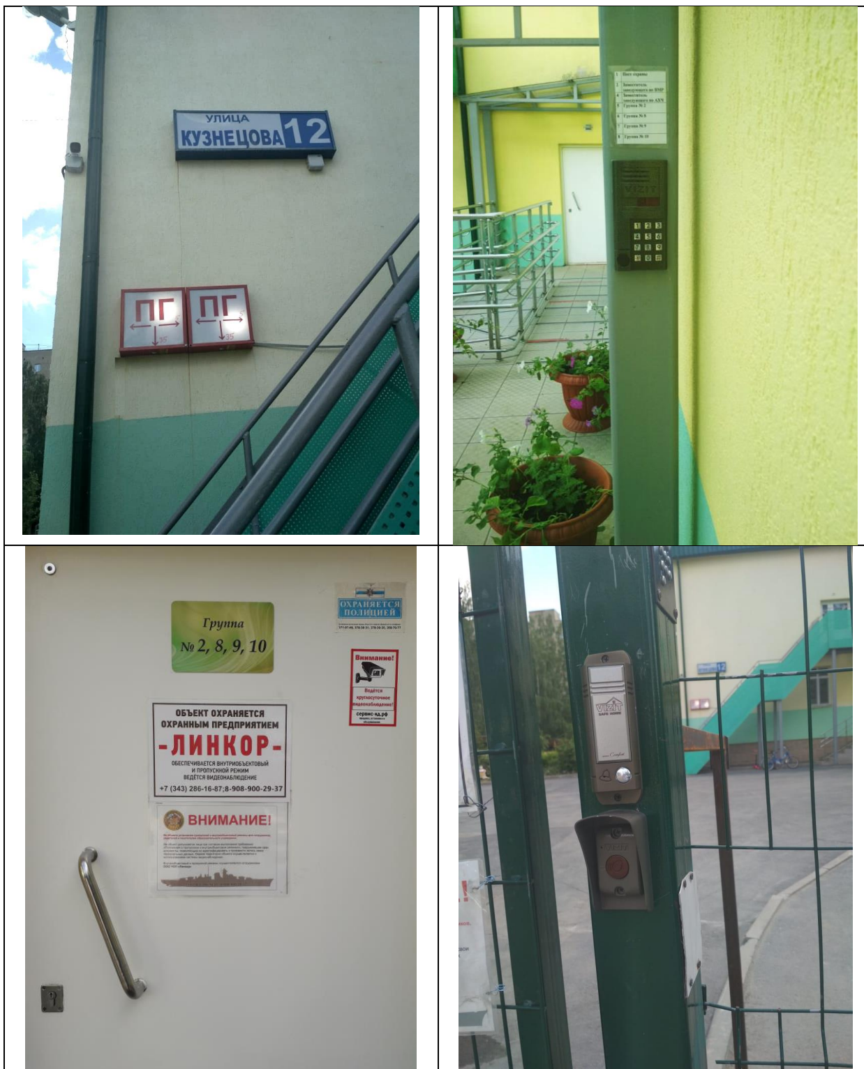
Рисунок 9. Техническое обеспечение комплексной безопасности. МАДОУ детский сад № 531, г. Екатеринбург
